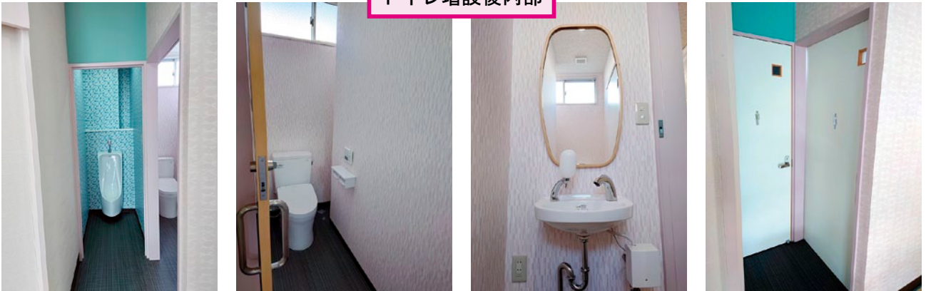
トイレ増設後内部
