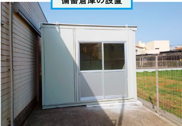
備蓄倉庫の設置
