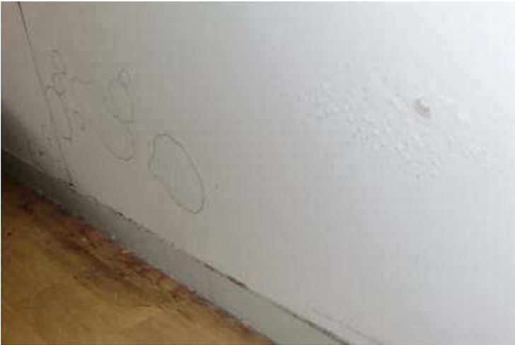
印の部分内部に漏水により水が溜まっている状態。
