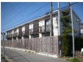
グリーンハイツ2（仮設備工事済・今後、傾きの復旧工事予定）
