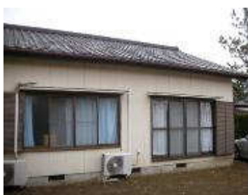
東棟（傾きの復旧工事済、ジャッキアップ・内装外装・外部給排水工事）
