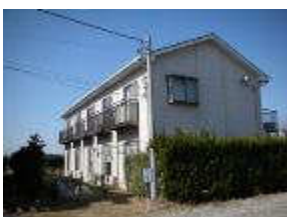
グリーンハイツ1（仮設備工事済・今後、傾きの復旧工事予定）
