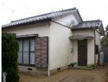
西棟（傾きの復旧工事済、ジャッキアップ・内装外装・外部給排水工事）
