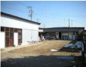
施設管理科と備蓄倉庫（傾きはあるが現状のまま使用）
