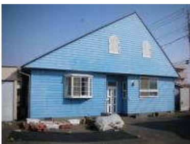
小宮ハウス（やや傾きはあるが、管理人室と一時保護事業として使用）
