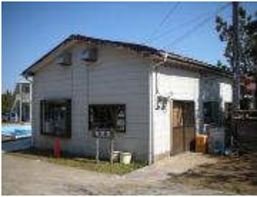
陶芸室（設備工事済・傾きはあるが現状のまま使用）
