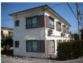
研修棟（設備工事済・やや傾きはあるが、現状のまま使用）
