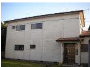
男子寮（やや傾きはあるが、そのまま使用・浄化槽と排水経路がやや逆勾配）
