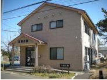
職員会館（設備工事済・やや傾きはあるが現状のまま使用）
