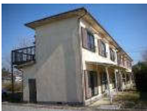
女子寮（解体予定）
